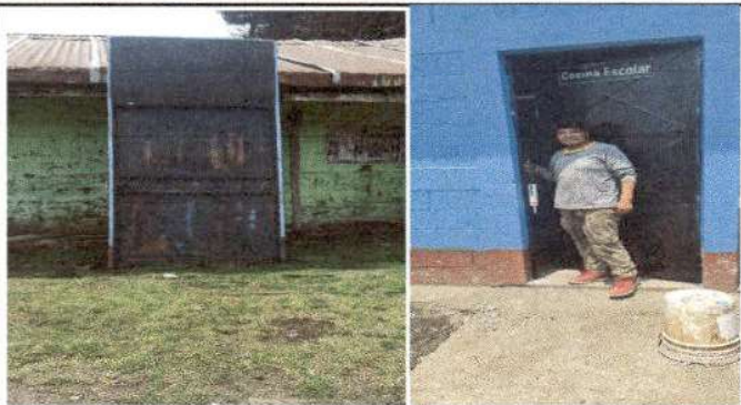
Foto1: Las puertas ya construidas y en proceso de instalación
