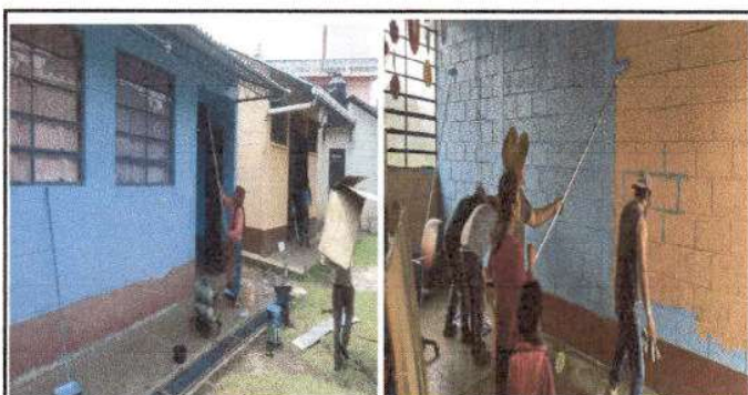
Foto 6: Pintura en muro en proceso
