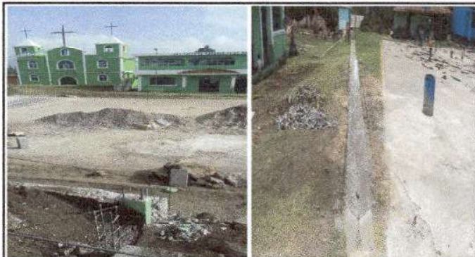
Foto 2: Cuneta en proceso de reparación
