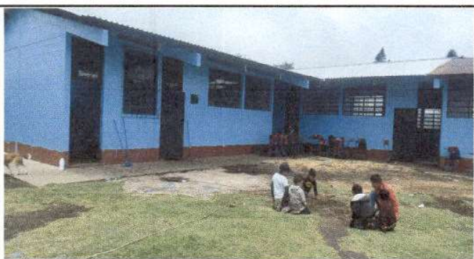
Foto 3: Pintura en muro en proceso
